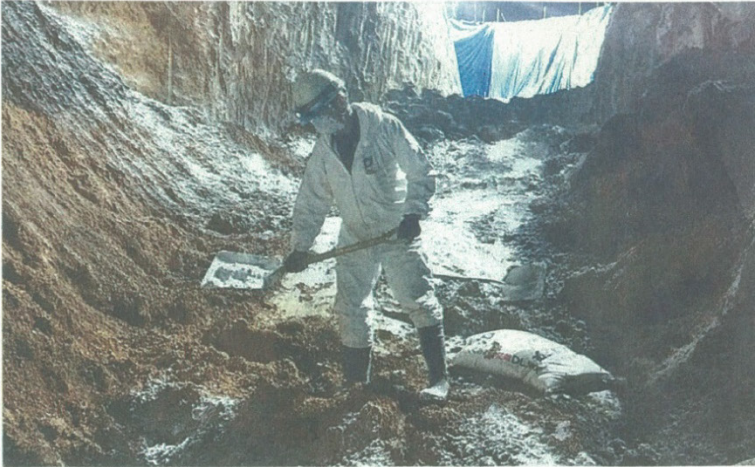
殺処分した豚を埋めるための溝を掘る作業員（2020年9月、高崎市）＝県建設業協会提供
