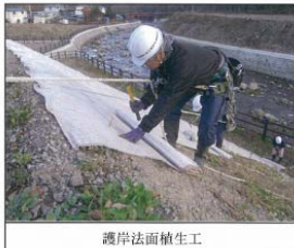
護岸法面植生工
