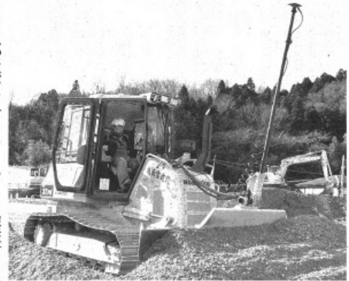
道路工事でICT対応のブルドーザーを使う南雲建設
