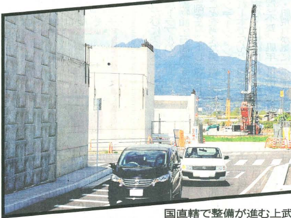
国直轄で整備が進む上武道路の工事現場
